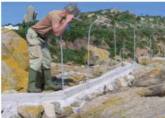
Mise en place des piquets métalliques.
