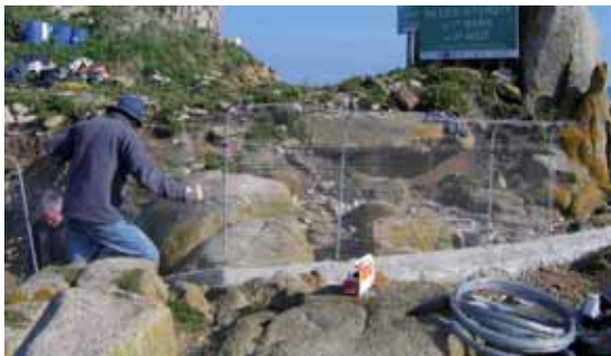
Fixation du grillage par tronçons de 3 à 4,5 mètres avec des colliers Colson®.
