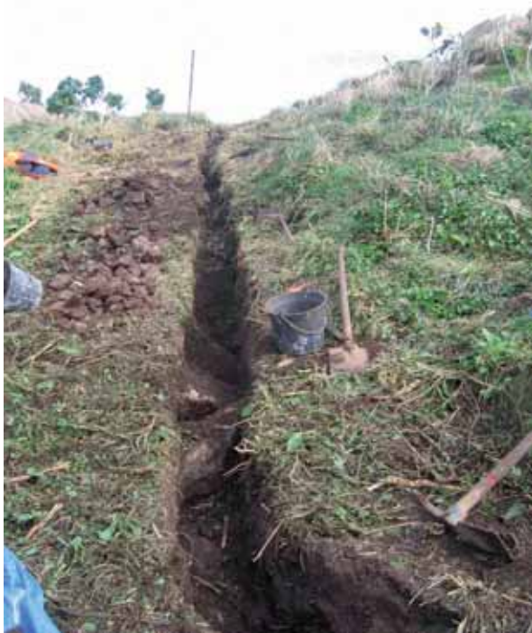
La tranchée, versant ouest.
