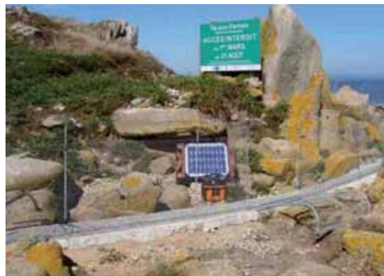
Poste d'électrification des fils de clôture placés à l'extrémité extérieure du grillage et à mi-hauteur de celui-ci.
