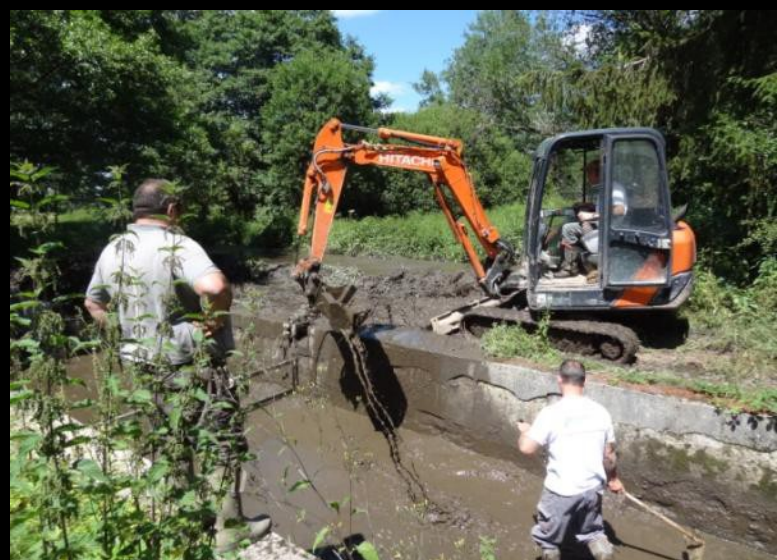
Curage mécanique Coût : 1 600 euros HT
