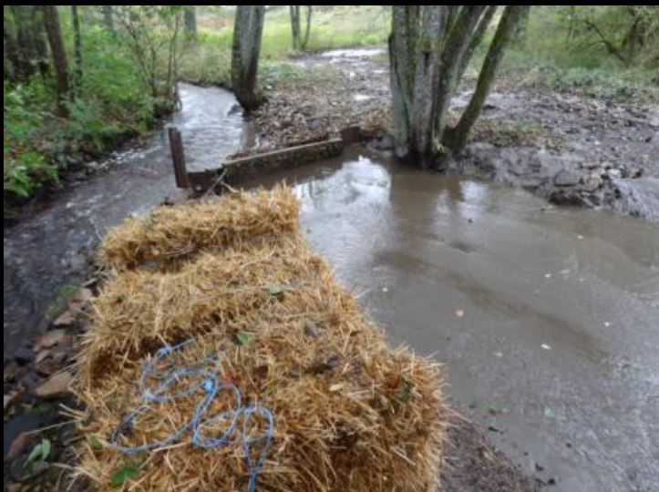
Création d'un nouveau filtre à paille Coût : 305 euros HT
