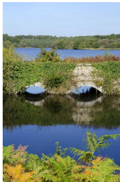
Retenue de Kerné-Uhel
