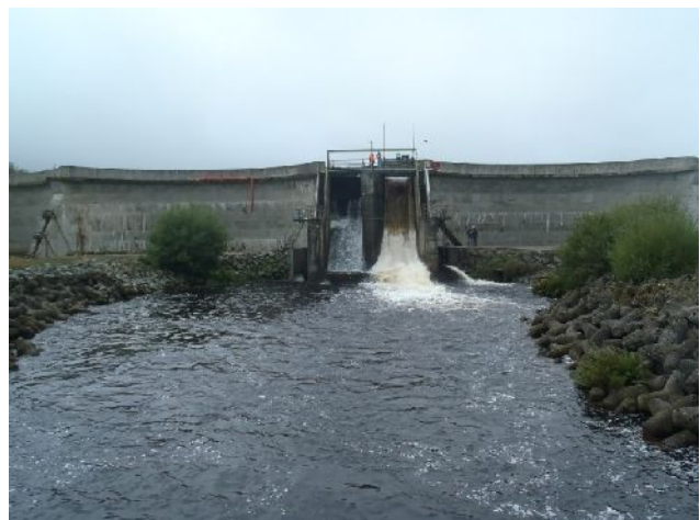
Barrage : obstacle à la migration des poissons et des sédiments
