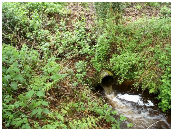
Buse infranchissable pour la truite fario située sur un affluent du Dour Vern, à proximité de Kerrolland
