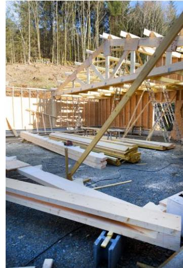
Figures 5 et 6 : ossature bois et charpente
