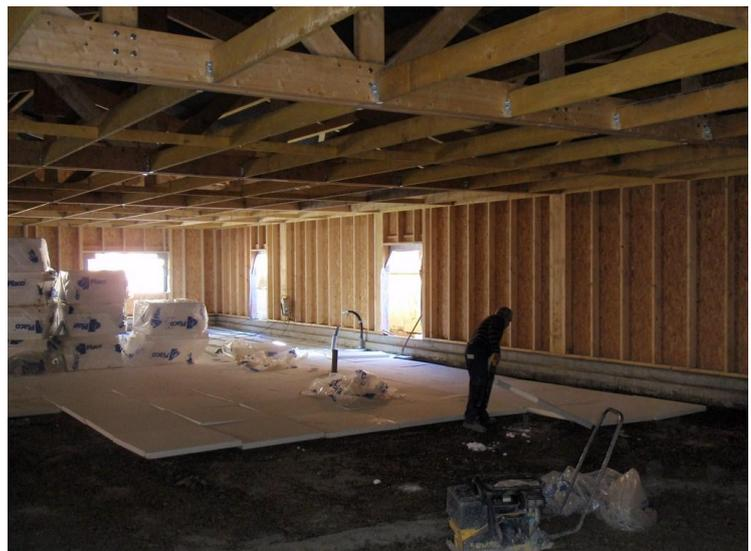
Figure 4 : Préparations pour coulage de la dalle
