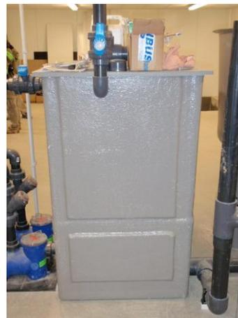
Figure 11 : bâche tampon circuit fermé
