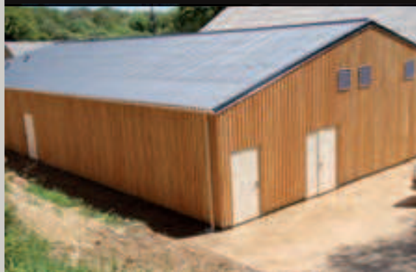
Vue extérieure de la station d'élevage
