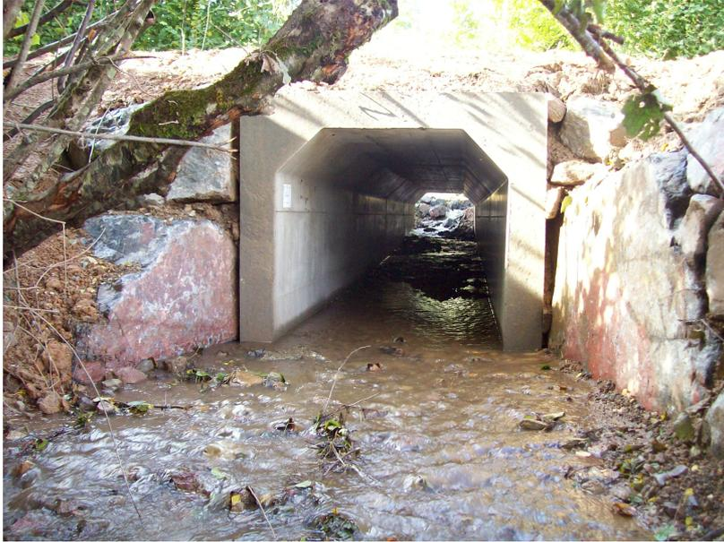
**Photo 1 : Pont cadre installé sur le bassin du Sarthon**
