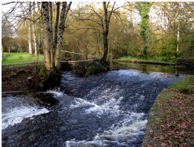
Seuil de moulin : obstacle à la migration des poissons et des sédiments Photo : Y. Merle (Syndicat de la vallée du Blavet)
