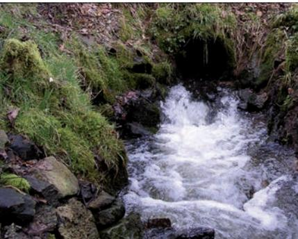
**Avant travaux : buse infranchissable et sous-dimensionnée par rapport au débit moyen.**
