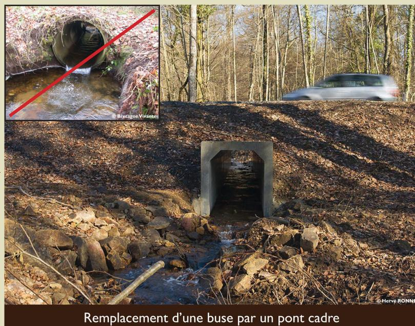
Remplacement d'une buse par un pont cadre
