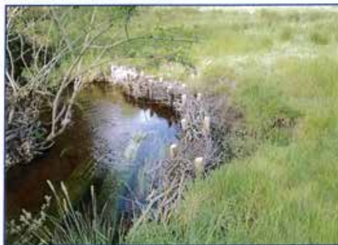
Fascine réalisée pour éviter l'érosion de la berge.
