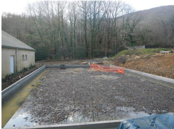
Chantier à la mi décembre 2011 (© Fédération de pêche du Finistère)
