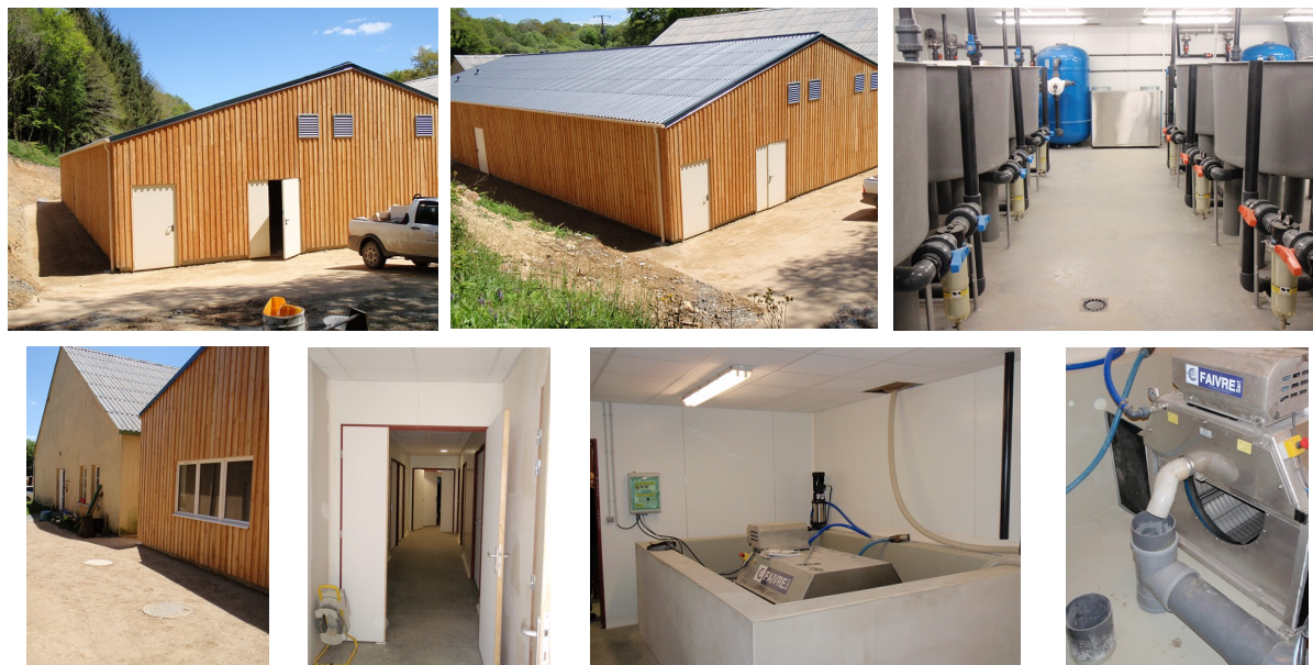
Bâtiment vues de l'extérieur, bassins intérieurs et traitement de l'eau (© Bretagne Vivante)
