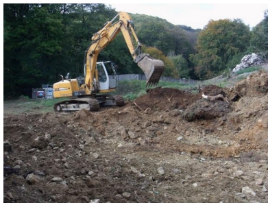
Travaux de terrassement (© Fédération de pêche du Finistère)
