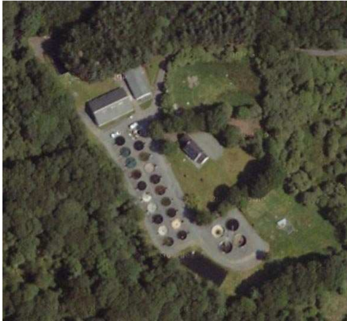
VUE AERIENNE DU SITE A L'ETAT ACTUEL
